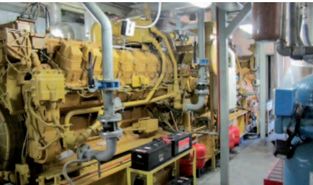
Figura 4. Heat & Power: cogenerazione presso Pasta Zara – stab. di Muggia (TS). Motore a c. i. 2 MWe
